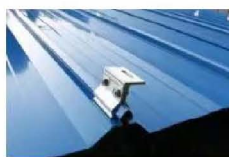
(彩钢瓦屋面示意图) 与屋面平行安装
