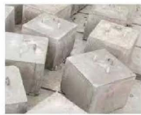
(混凝土屋面示意图) 水泥墩为底座
